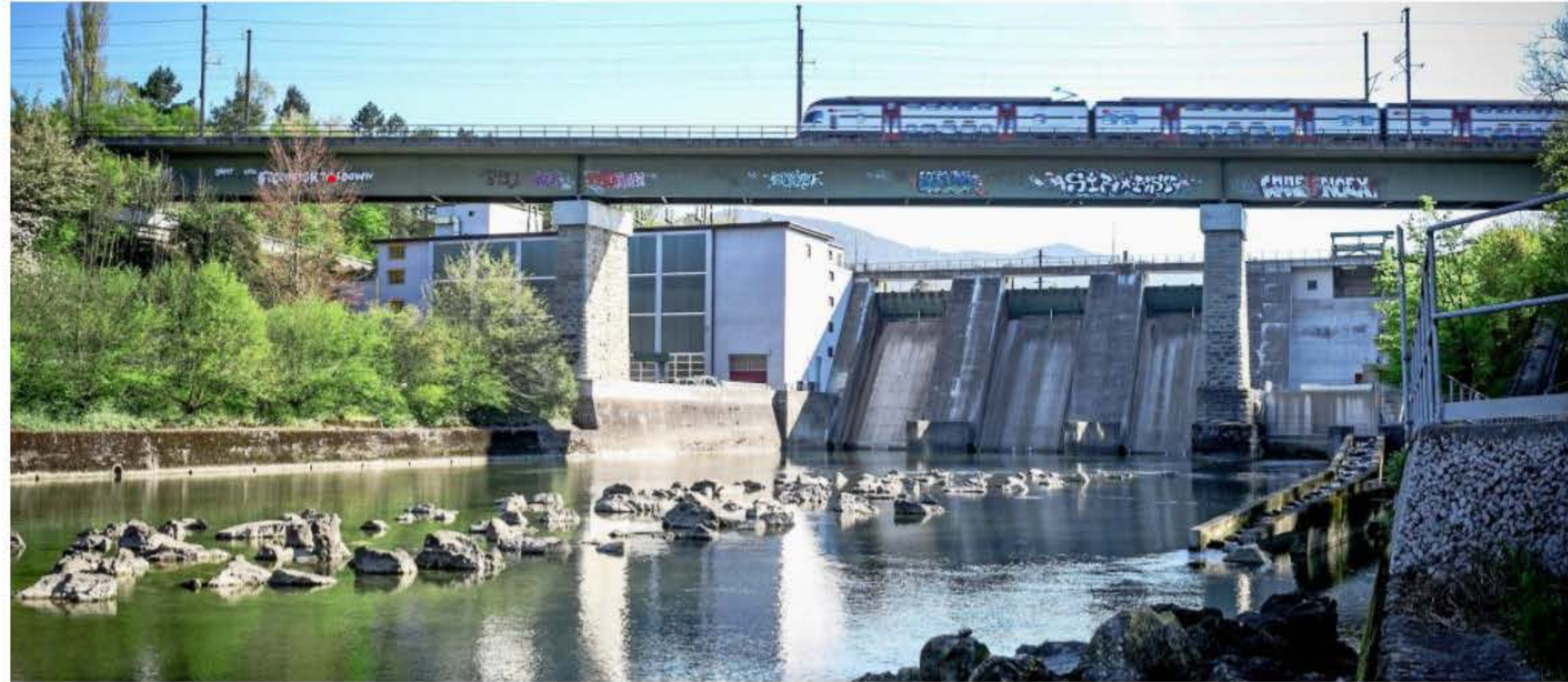
Das Kraftwerk Wettingen-Neuenhof.
